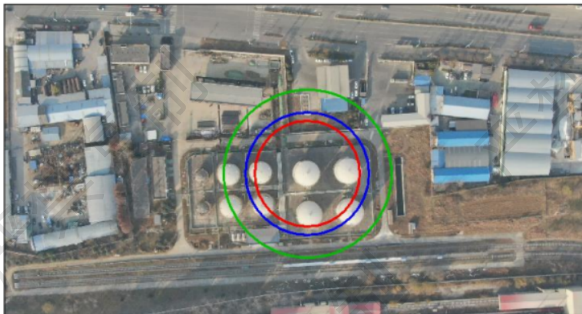
图2#柴油储罐（容器整体破裂）池火灾事故伤亡范围 事故后果分析结果：死亡半径35m，重伤半径41m，轻伤半径56m。
