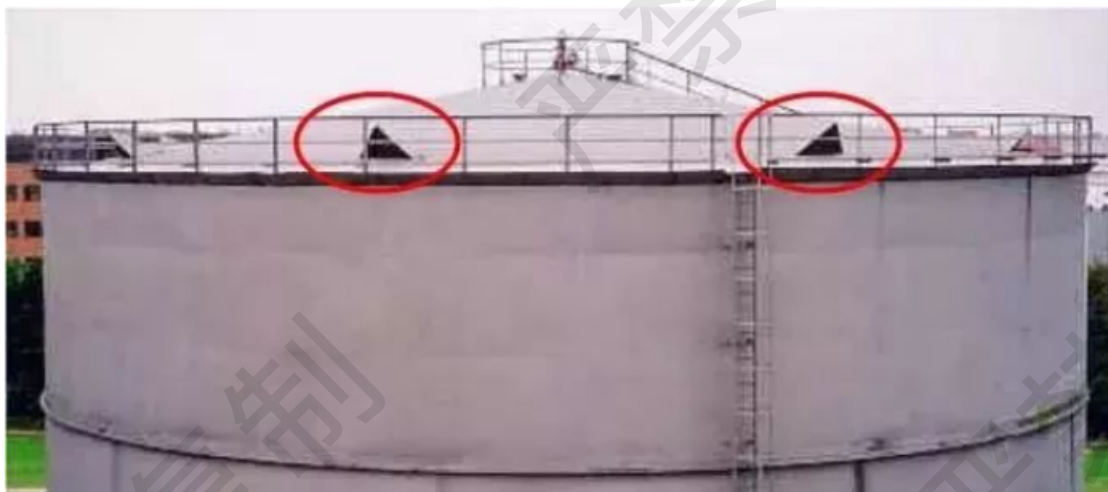
储罐顶部三角形排气口
