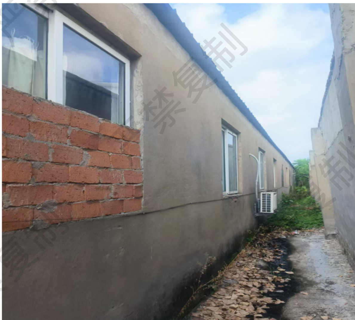
南侧丙类厂房（整改前）
